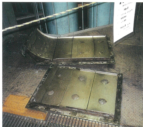
これまでライナーの取付工事を繰返して来た。 セラミックスタイルの貼付により、開放、取替え工事が 不用となる。
