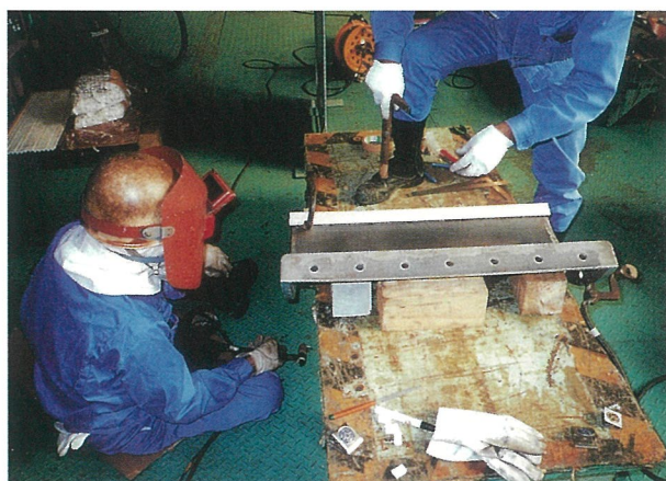
タイル枠を溶接で固定
